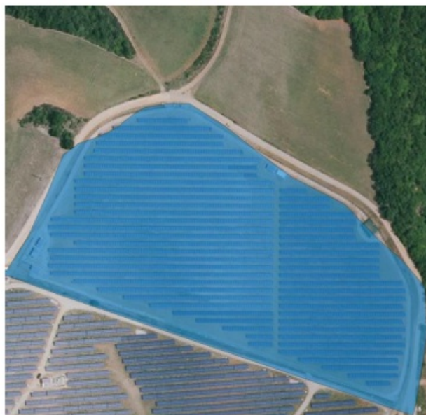
Ou enfin d'un champ photovoltaïque
