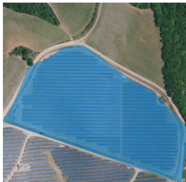
Ou enfin d'un champ photovoltaïque
