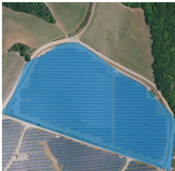
Ou enfin d'un champ photovoltaïque
